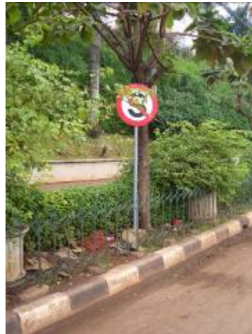
Tinggi rambu tidak standar
