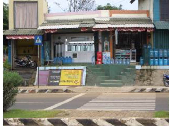
Rambu tempat penyeberangan disertai dengan marka
